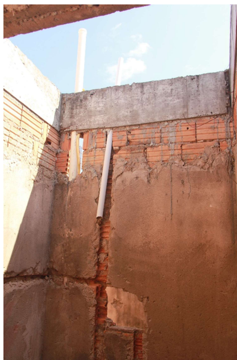
10: INTERNO – CORTE ALVENARIA/ INSTALAÇÕES HIDROSSANITARIA
