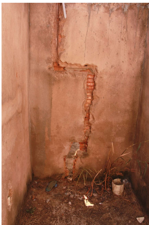
10: INTERNO – CORTE ALVENARIA/ INSTALAÇÕES HIDROSSANITARIA
