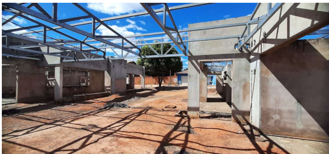
12: DETALHES INTERNOS - ESTRUTURA METALICA DA COBERTURA
