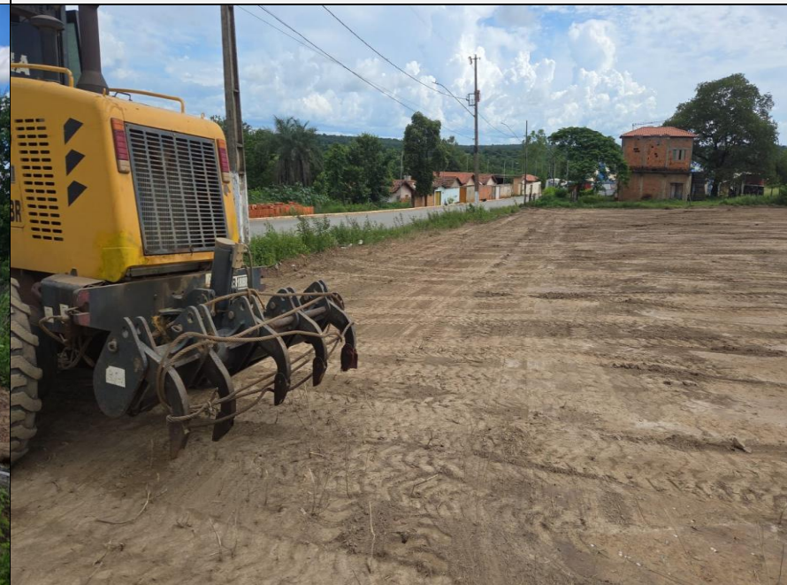
Descrição: Terreno a ser construído a UBS PORTE I (alvenaria), na Rua Principal, Distrito de Santana de Minas, zona rural de São Francisco –MG.
